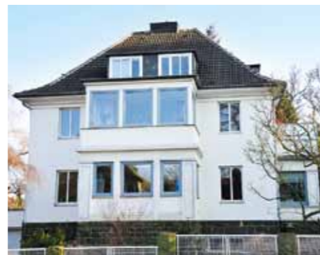
Tradition und Moderne: Bei diesem Geschäftshaus einer Privatbank in Kassel-Bad Wilhelmshöhe hat die engagierte Architektin Cornelia Issmer-Pfomm (Architekturwerkstatt Kassel) den alten Baukörper (ca. 1930) mit weißen Holzfenstern nach historischem Vorbild versehen lassen, alle Anbauten aus den 60er Jahren mit modernen Kunststofffenstern.
