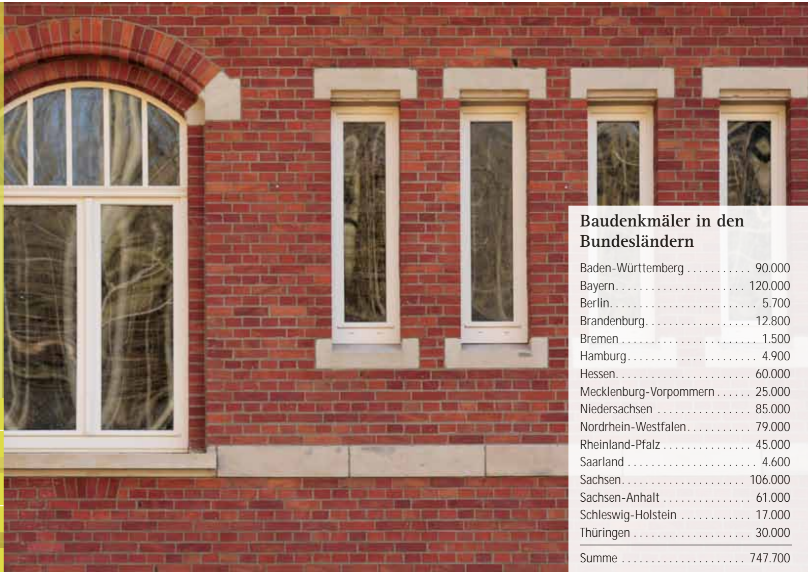
Stiftsklinik im Kaufunger Wald bei Kassel im viktorianischen Baustil. Die Firma Walter setzte „Amsterdam Line“ in Cremeweiß auf der Basis von TOPLINE AD ein.
