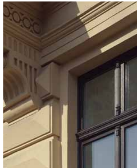
Detail der Fassade in Halle (S. 5): Nach Einbau und Begutachtung eines Musterfensters mit detailreichen Zierelementen waren die Vertreter der Denkmalschutzbehörde überzeugt, dass ihre Anforderungen mit dem Kunststoffsystem erfüllt werden.
