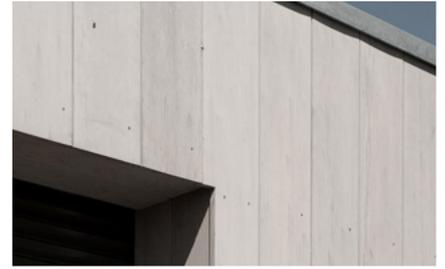
Damit sie perfekt zu Wasserschlag und Sonnenschutz passen, wurden die Rahmen mit einer individuellen Vorsatzblende verkleidet.
