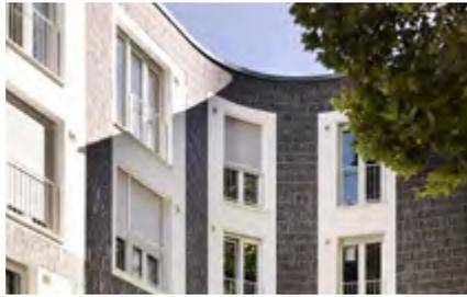
Die Riemchen auf den Klinkerfertigteilen wurden vertikal angeordnet, um Rundungen ohne Sonderformate herstellen zu können.
